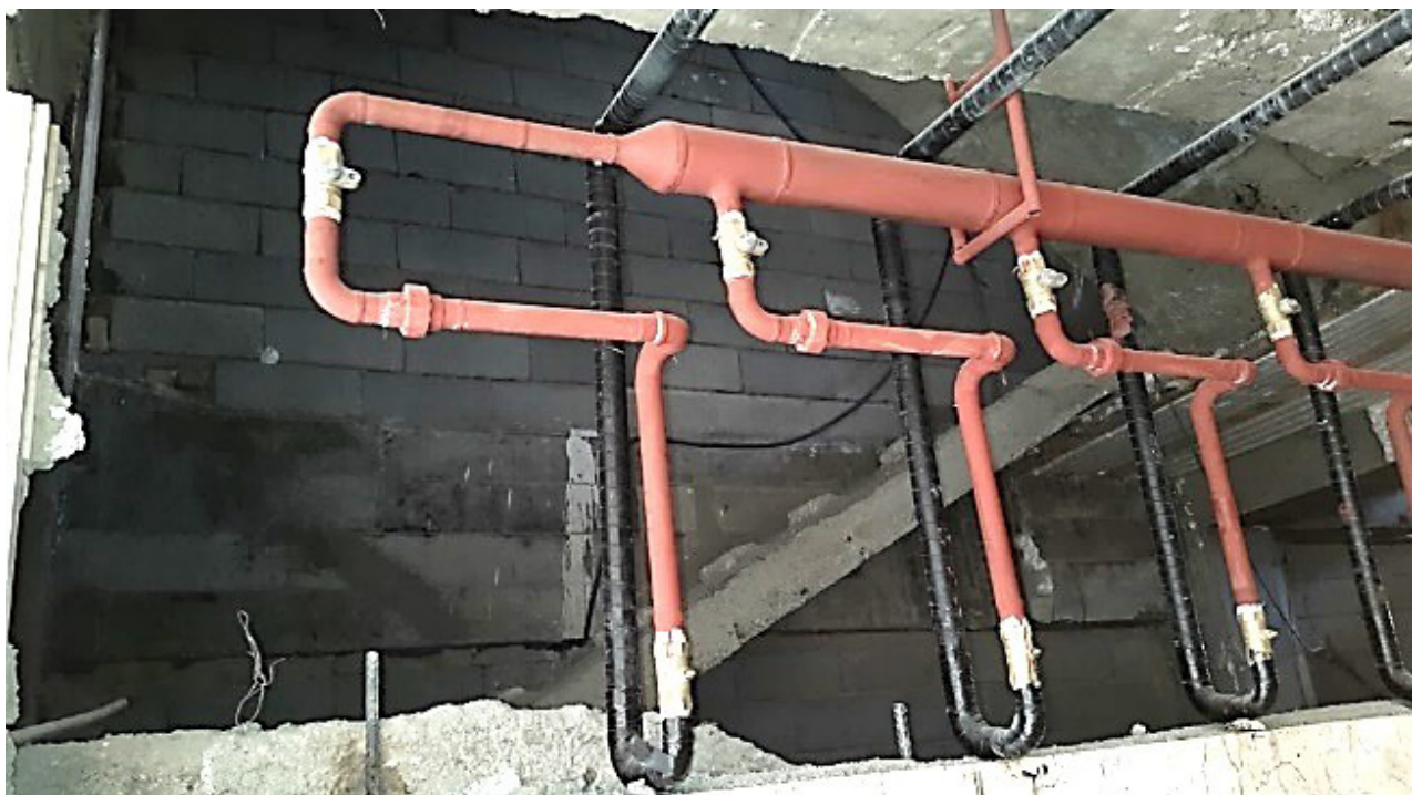
شکل شماره (۷) لزوم نصب تبدیل به انتهای کلکتور به قطر آخرین انشعاب از آن برای ایجاد جریان
