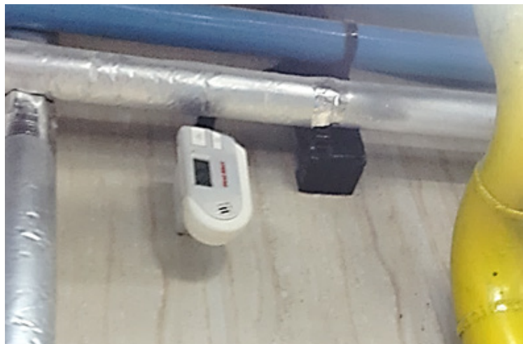
نمونه سنسور حساسی به گاز منواکسیدکربن و دود مجهز به اعلام خطر در موتورخانه ها
