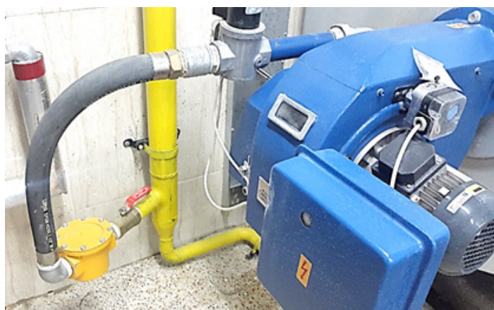
نمونه لوله‌کشی گاز به صورت روکار در موتورخانه‌ها و نحوه
