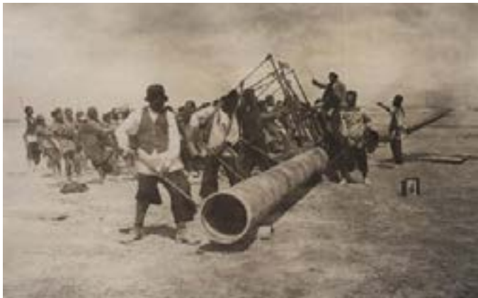
کارگران در حال لوله‌کشی و لوله‌گذاری
